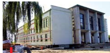
Obecnie trwa remont UL, który przez kilkanaście lat stał zaniedbany
