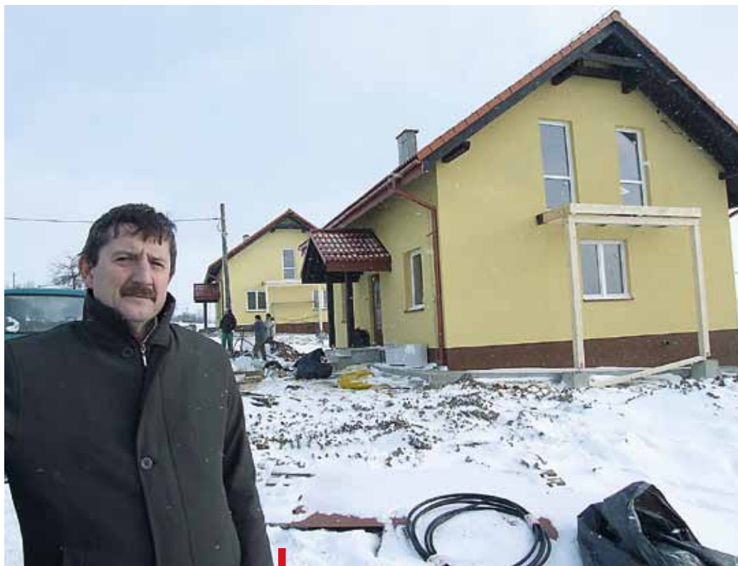
– Domy wybudowaliśmy w 3,5 miesiąca – mówi Stanisław Piegza, prowadzący budowę urzędnik z gminnego samorządu
