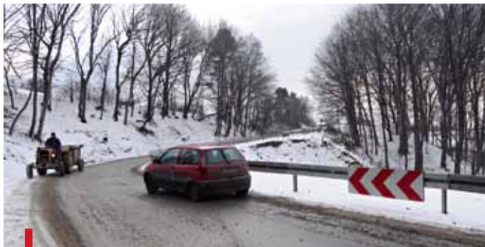
Przejazd przez osuwisko w Kurowie, choć prowizoryczny, ma się zupełnie dobrze
