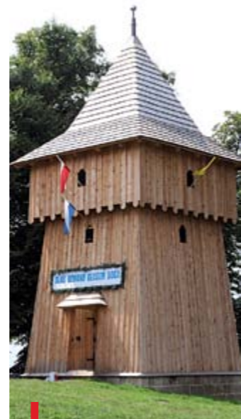
Po odbudowie dzwonnica wygląda jak przed pożarem
