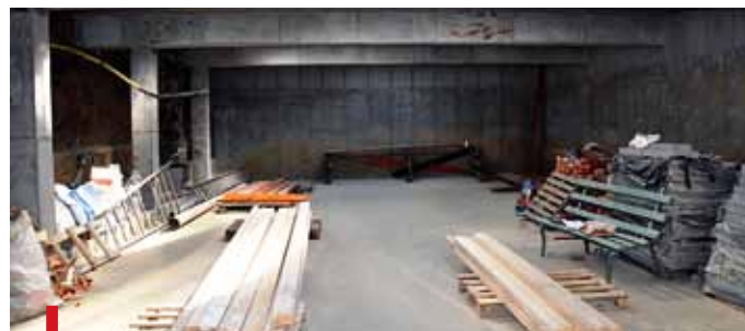
Budowana sala duszpasterska pomieści 250 osób
